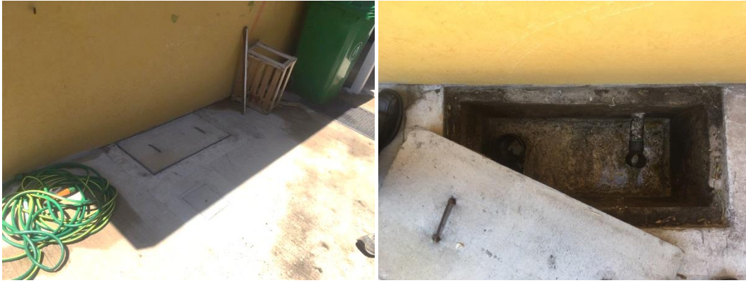
Grasera IG1: como se puede observar en las fotos no coincide con el detalle anterior
